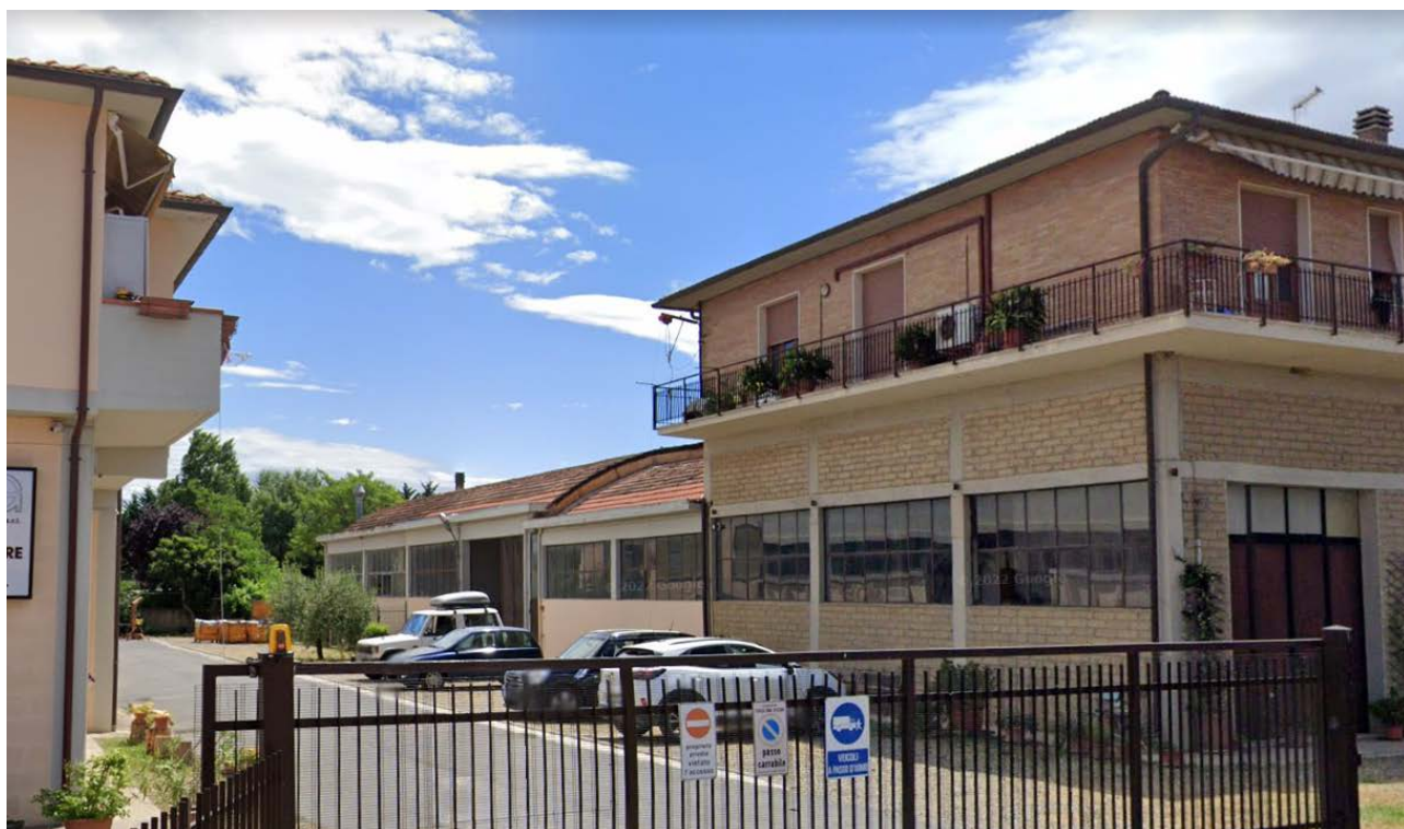
Foto 5 – L'intenzione sarebbe poi quella di avere la possibilità di intervenire anche nelle parti adiacenti posteriormente al fabbricato a due piani e riqualificare la zona verso il residenziale.
