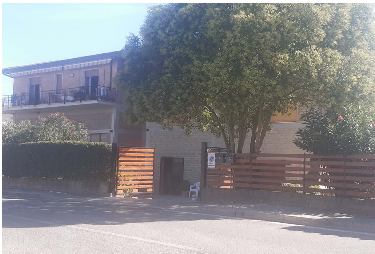
Foto 4 – Foto fronte strada.
