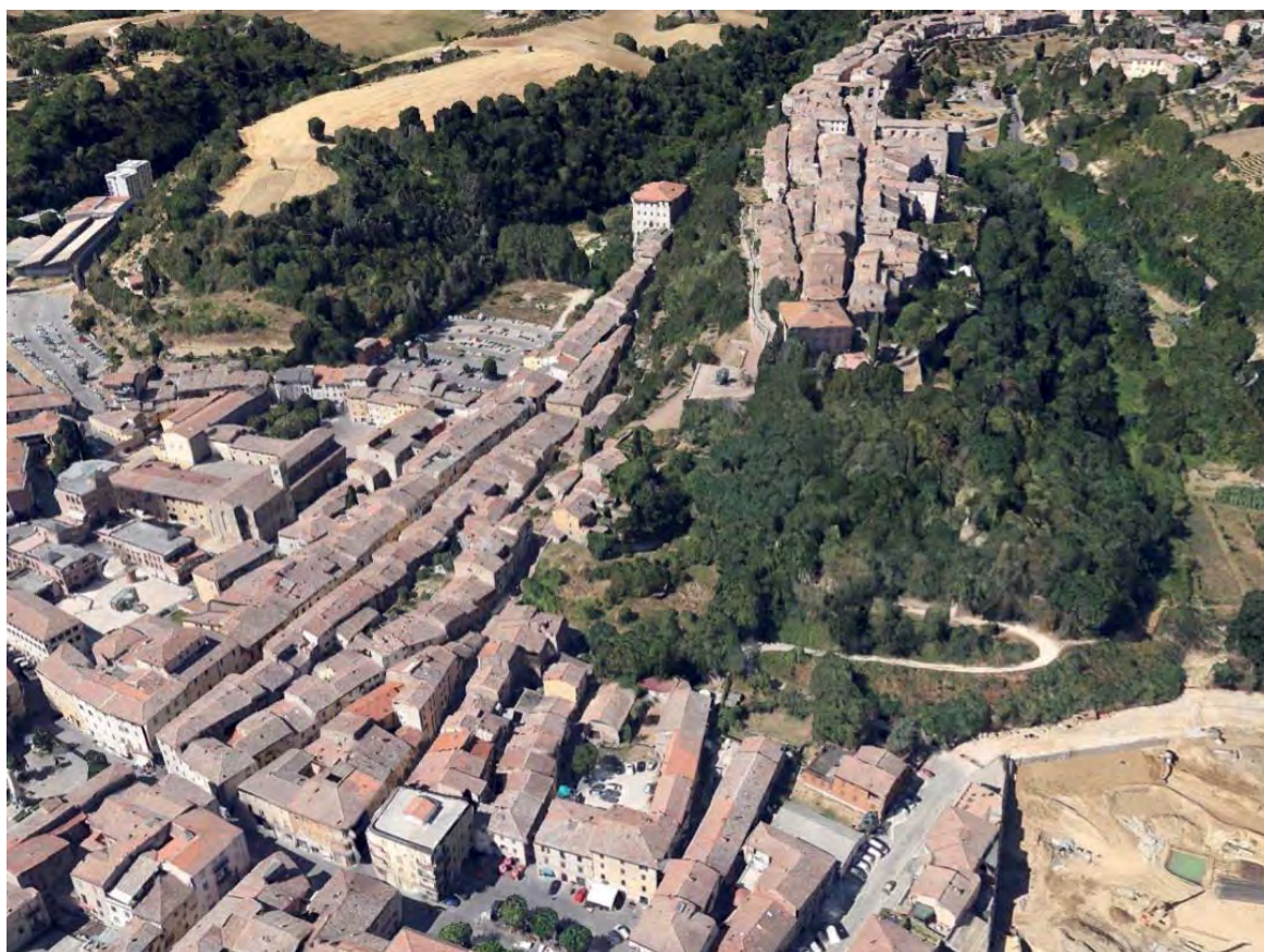
Fig. 61 – Inquadramento dall'alto dell'area di rigenerazione
