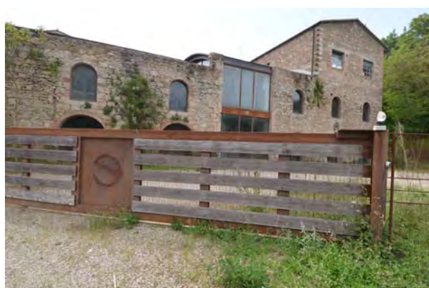
Fig. 47 – Inquadramento degli edifici nella parte a nord dell'area
