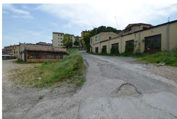
Fig. 45 – Inquadramento degli edifici sotto via della Lisciata verso il fiume
