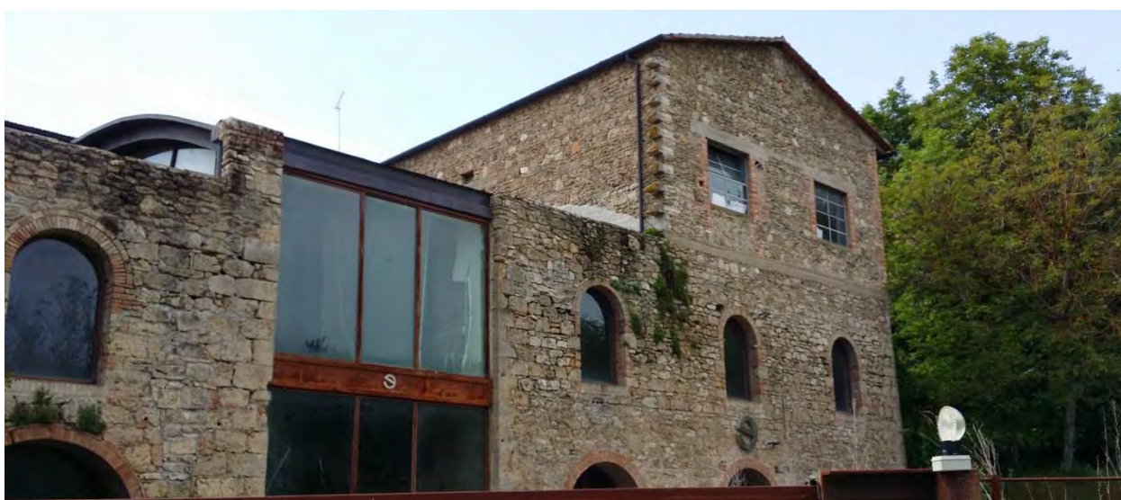
Fig. 16 – Ex officina metalmeccanica lungo l'alveo dell'Elsa, da sottoporre a intervento di restauro e risanamento conservativo (3,4,5,6,7)
